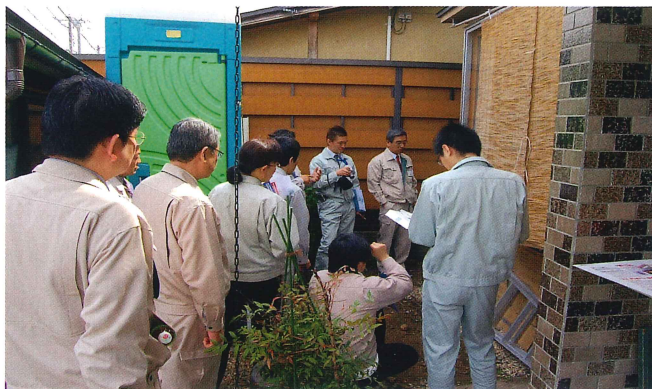
【県・各市町村の耐震診断士に対する基礎補強工事現地説明会状況】
