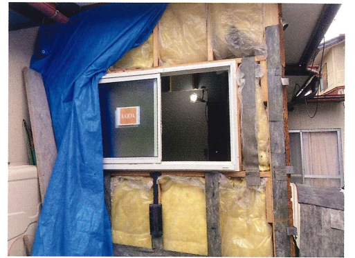
【リフォーム解体作業】
